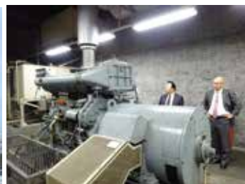
当面の活用が決まった静岡市清水庁舎。4Fに設置されている非常用発電機（=右写真）地階の電気室には防潮扉も設置されている。
